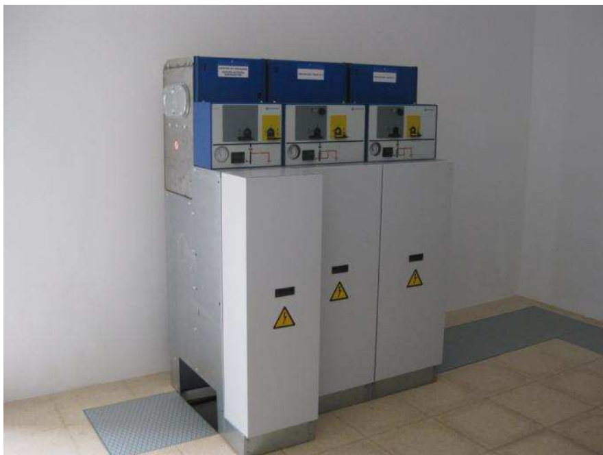
Ejemplo de celdas de línea y protección de trafa
